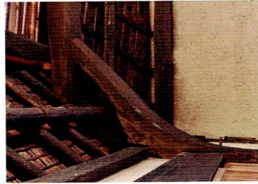
股柱(非公開) 画像提供：金鳳山平林寺 二股に分かれた天然木を使用しており、これにより豪雪地帯でも耐えられる強度と天井の高さを両立しています。
